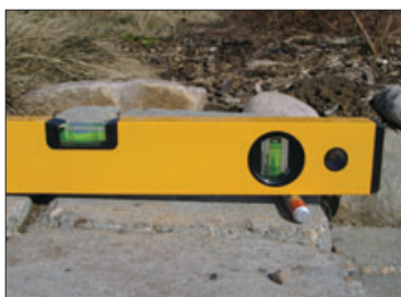
Find en passende genstand ca. 1 cm tyk til at placere under vaterpasset. Så er det nemt at lave det rette fald.
