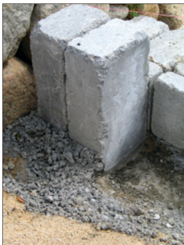
Betonblokkene skal bankes godt ned i den jordfugtige beton. Bagefter laves trekantstøbningen bagved.
